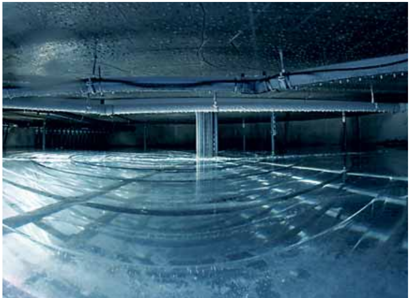
Die Kristallisationsprozesse im Eis-Energiespeicher können per Kameraübertragung visualisiert werden.
