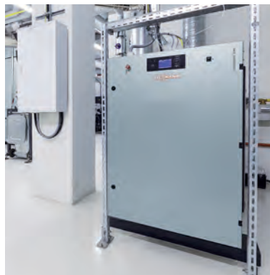
Blockheizkraftwerk Vitobloc 200 EM-20/39 mit Leistungen von 20 kW el und 39 kW th
