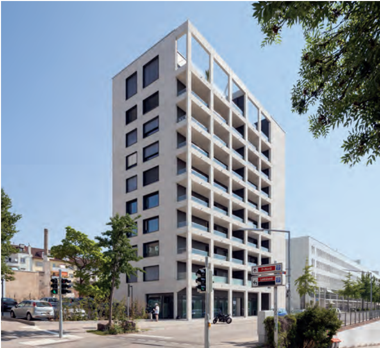
Das generalsanierte Wohnhochhaus in Pforzheim setzt zu hundert Prozent auf regenerative Energiequellen.
