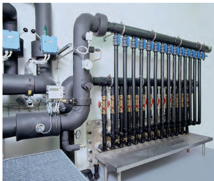
Erdsondenverteiler
