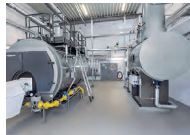
Dampferzeuger Viomax HS (links) mit thermischer Vollentgasung TWA-V (rechts)
