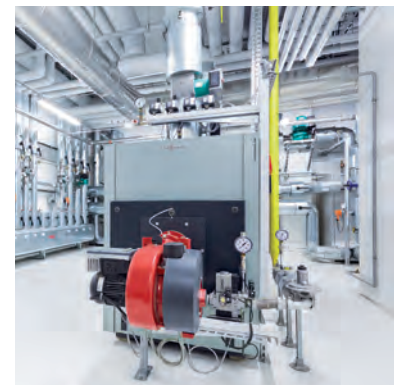
Der Gas-Brennwertkessel Vitocrossal 300 (Typ CR3B) ist für eine Leistung bis 787 kW ausgelegt und dient als Spitzenlastkessel.
