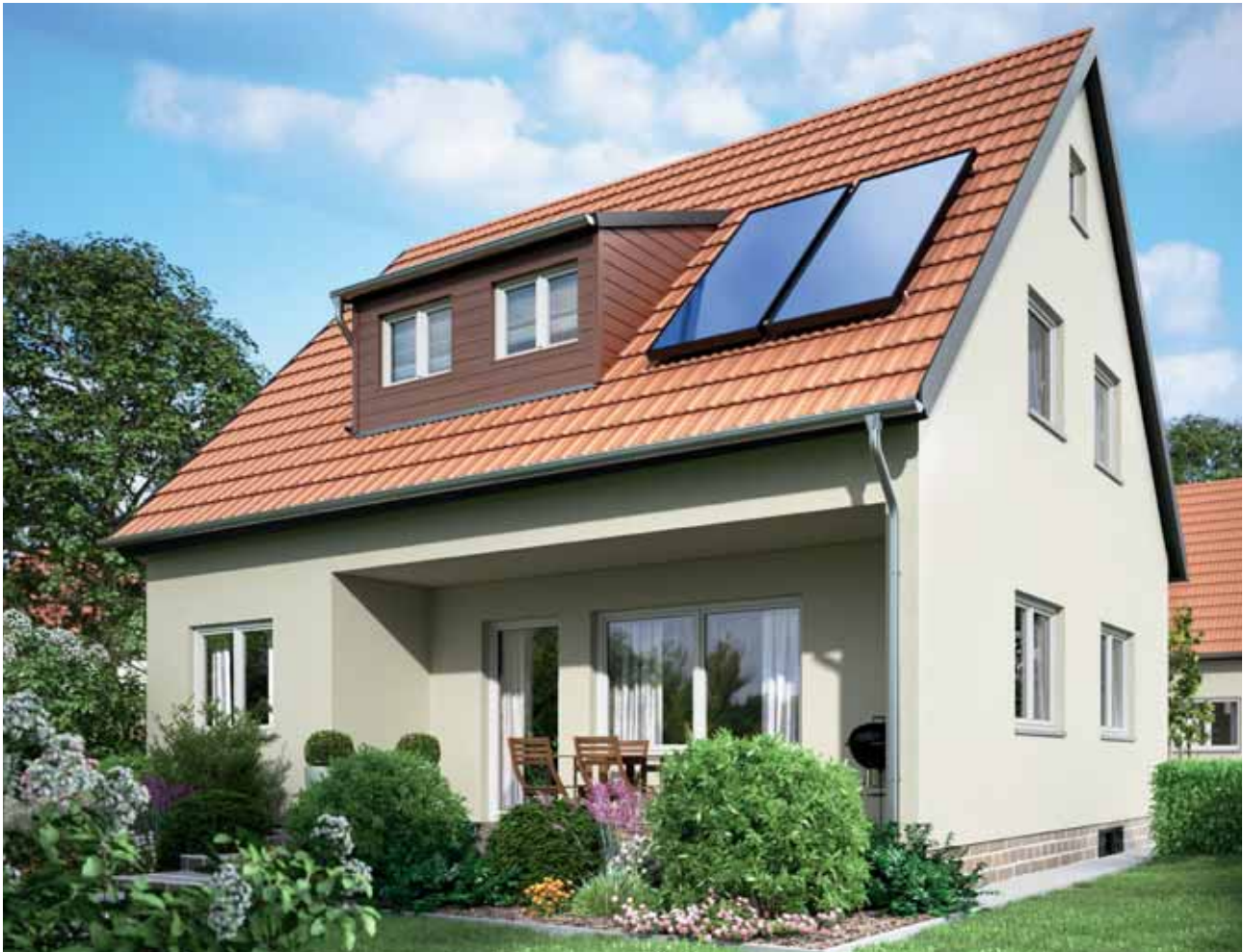
Vitosol 200-FM auf dem Dach eines Einfamilienhauses
