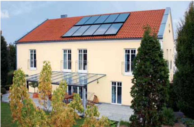
Vitosol 200-FM Zweifamilienhaus Geisenfeld
