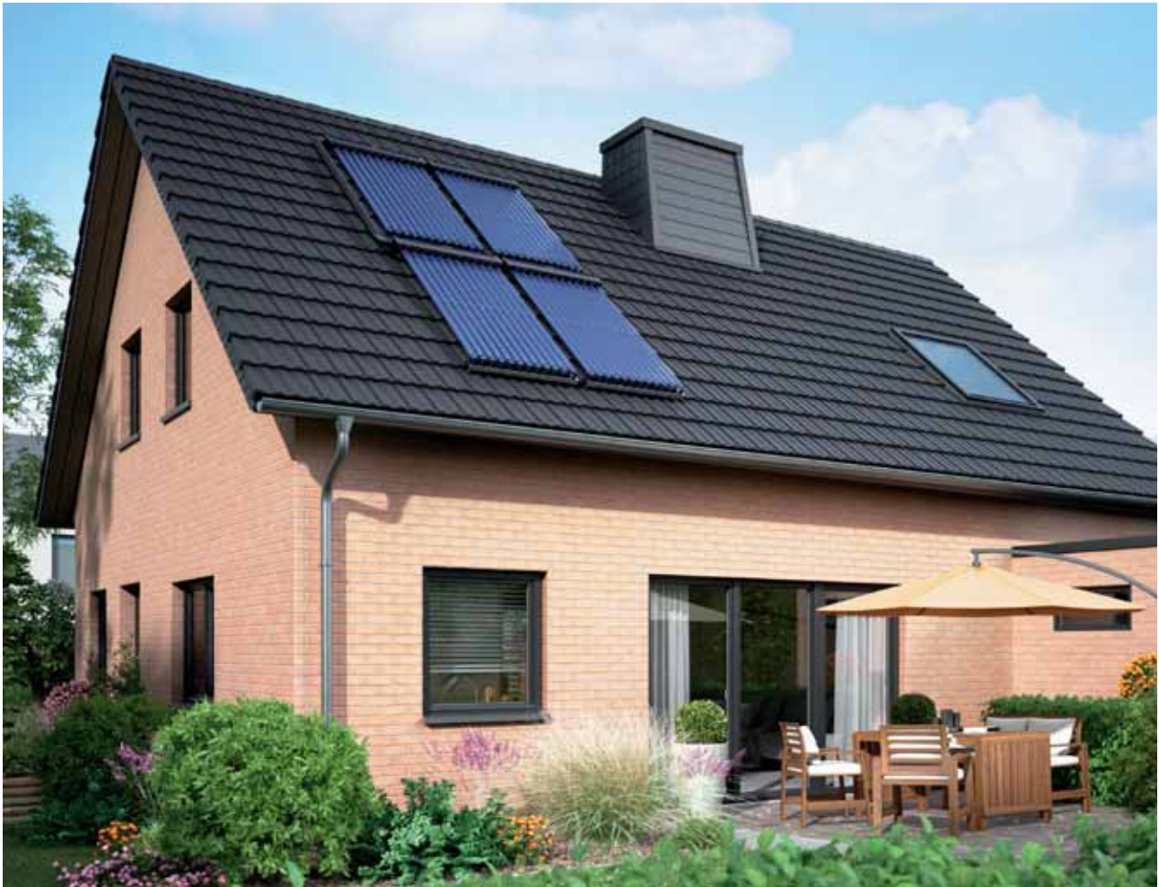
Vitosol 300-TM auf dem Dach eines Einfamilienhauses
